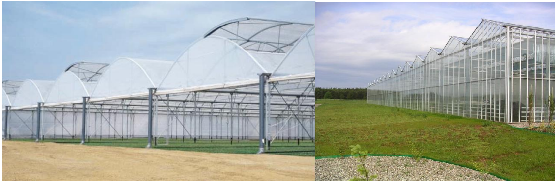
Стакленик са великом запремином и пластичним покривачем и стакленик
